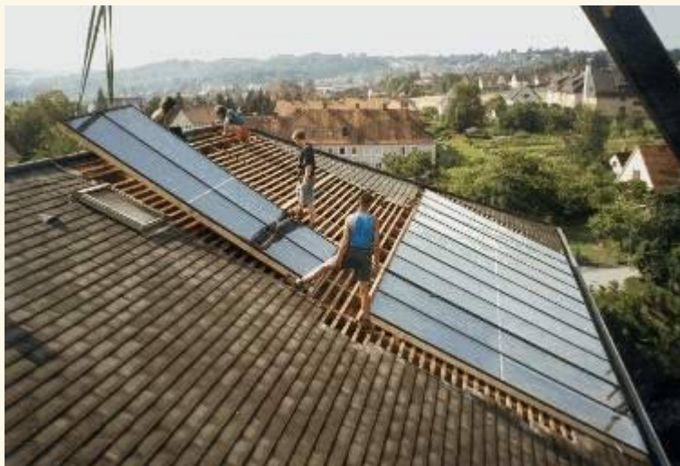
Obr. 4. Integrace velkoplošných kolektorů do střechy
