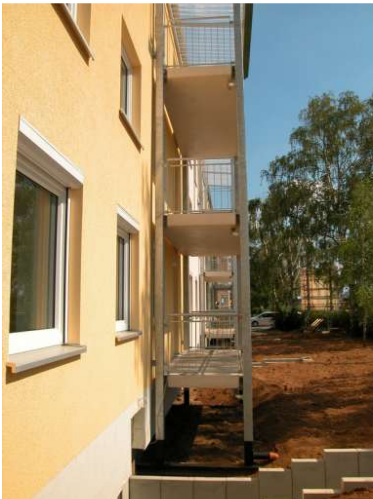
Tepelně oddělená samonosná konstrukce balkónů
