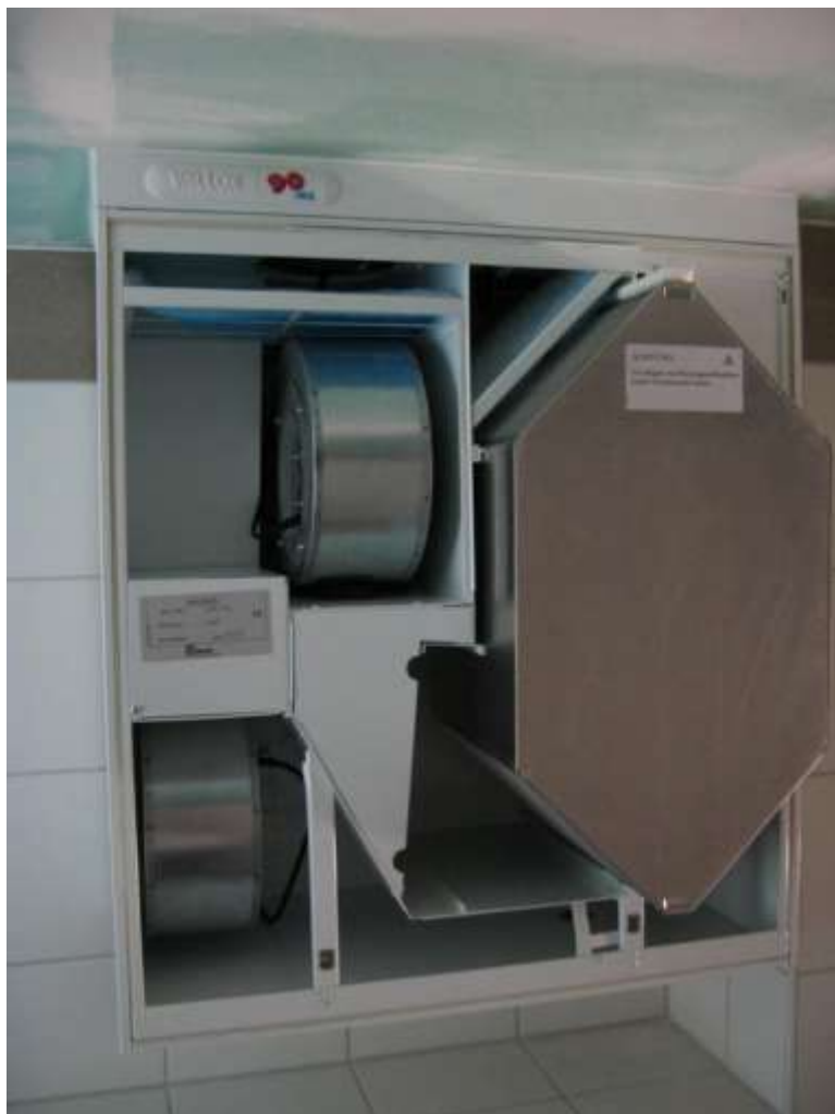
Větrací jednotka s rekuperací tepla v koupelně
