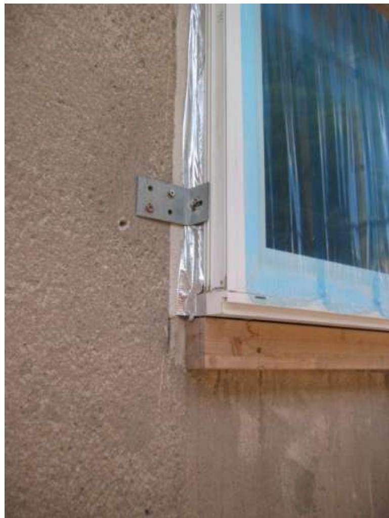
Osazení okna do roviny tepelné izolace
