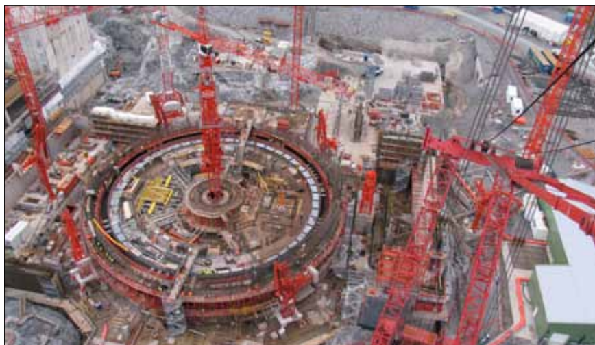
Stavba reaktoru EPR ve finském Olkiluoto.
